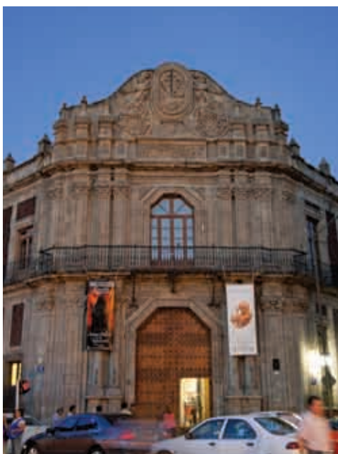
Fachada en pan-coupé del Palacio de la Inquisición, obra maestra del estilo barroco sobrio.
