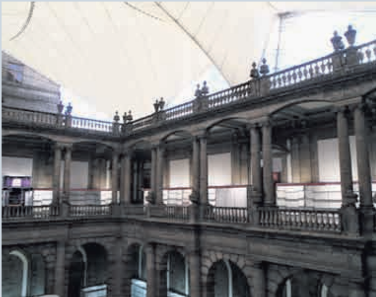
El techado del Palacio de Minería
